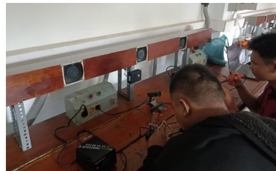
Gambar 15. Pengujian Box Sensor dan Kipas 1
