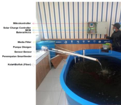
Gambar 2. Rangkaian Sistem Monitoring dan Kontrol Bioflok
